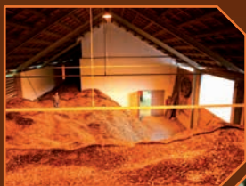
Obecní výtopna na biomasu.
