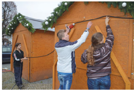
Budoucí elektromechanici si vyzkoušeli své schopnosti při zapojení elektrického proudu do stánků v adventním městečku v centru Lanškrouna.
