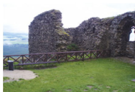
Truhláři, umělečtí kováři a zámečníci ze SPŠ stavební Pardubice zhotovili historické zábradlí na hradě Bezdězu.
